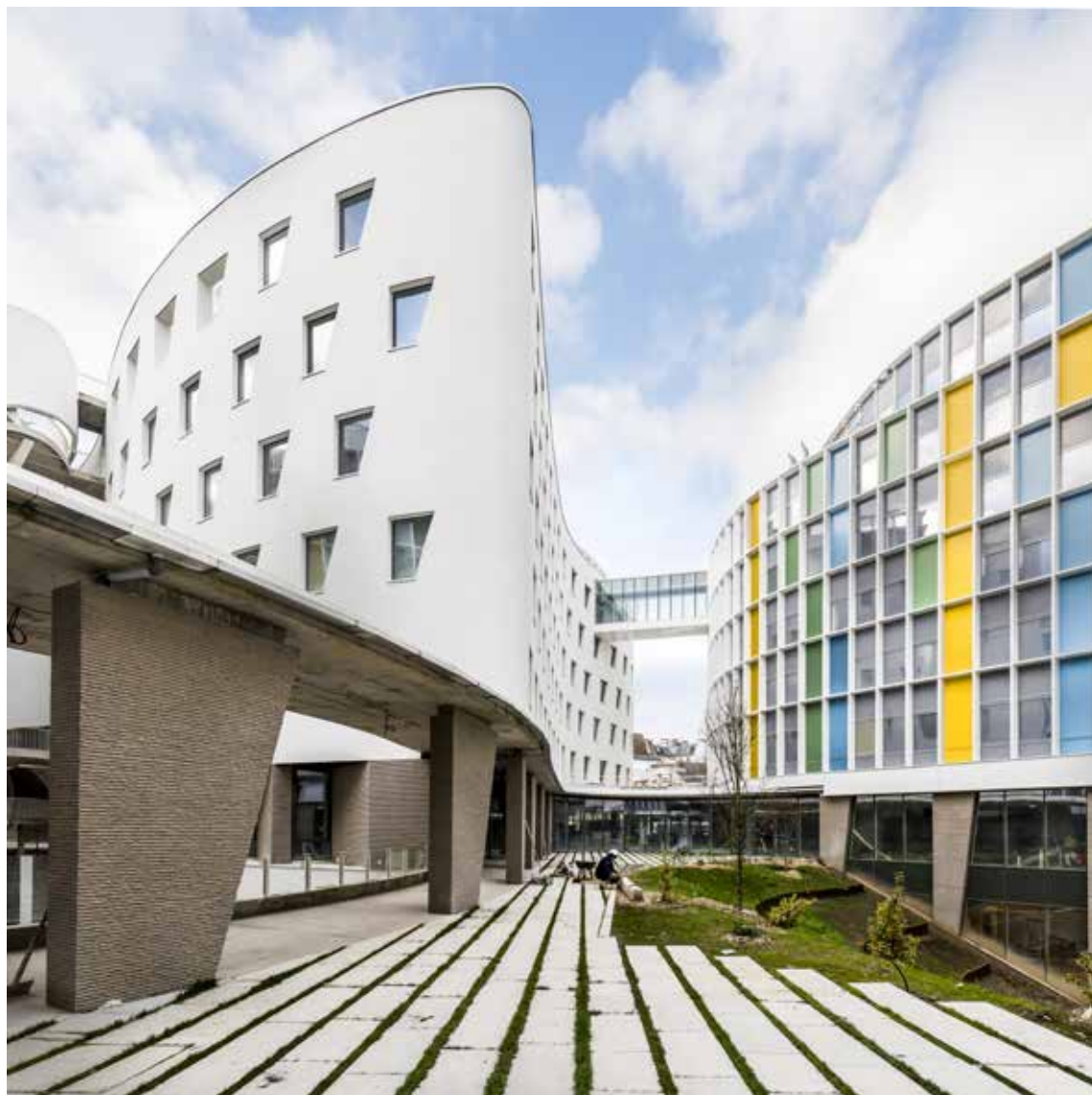
Le campus Picpus de l'université Sorbonne Nouvelle - Paris 3 - vue du cœur d'îlot / Le « cloître », chantier en cours Architecte : Christian de Portzamparc/2Portzamparc © Sylvain Cambon
