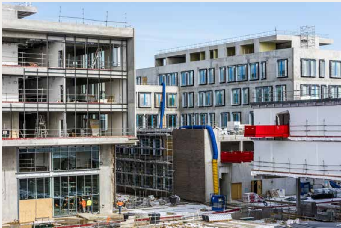
Chantier du projet Campus Agro Paris-Saclay, datant de février 2021, présentant l'un des bâtiments d'enseignement (à gauche), le bâtiment administratif (au centre) et ce qui deviendra le bâtiment emblématique du campus : le Forum (à droite) © Sylvain Cambon
