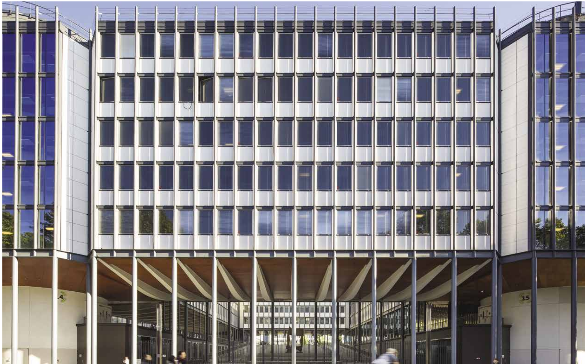
Après rénovation, le secteur ouest-centre du Campus Jussieu est directement accessible depuis la rue des Fossés-Saint-Bernard par un escalier extérieur qui rejoint le parvis. © Luc Boegly
