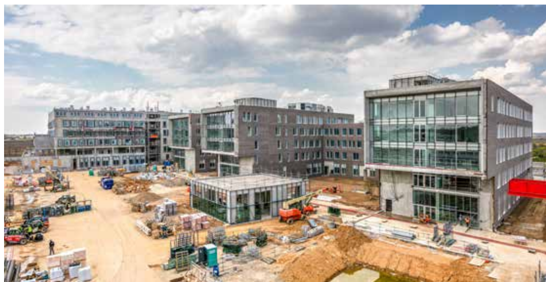
Chantier du projet Campus Agro Paris-Saclay, datant d'avril 2021, présentant l'un des bâtiments de recherche (au fond à gauche), les trois bâtiments d'enseignement pratique et théorique, et l'espace polyvalent étudiants (en premier plan). © Campus Agro SAS / Dronea
