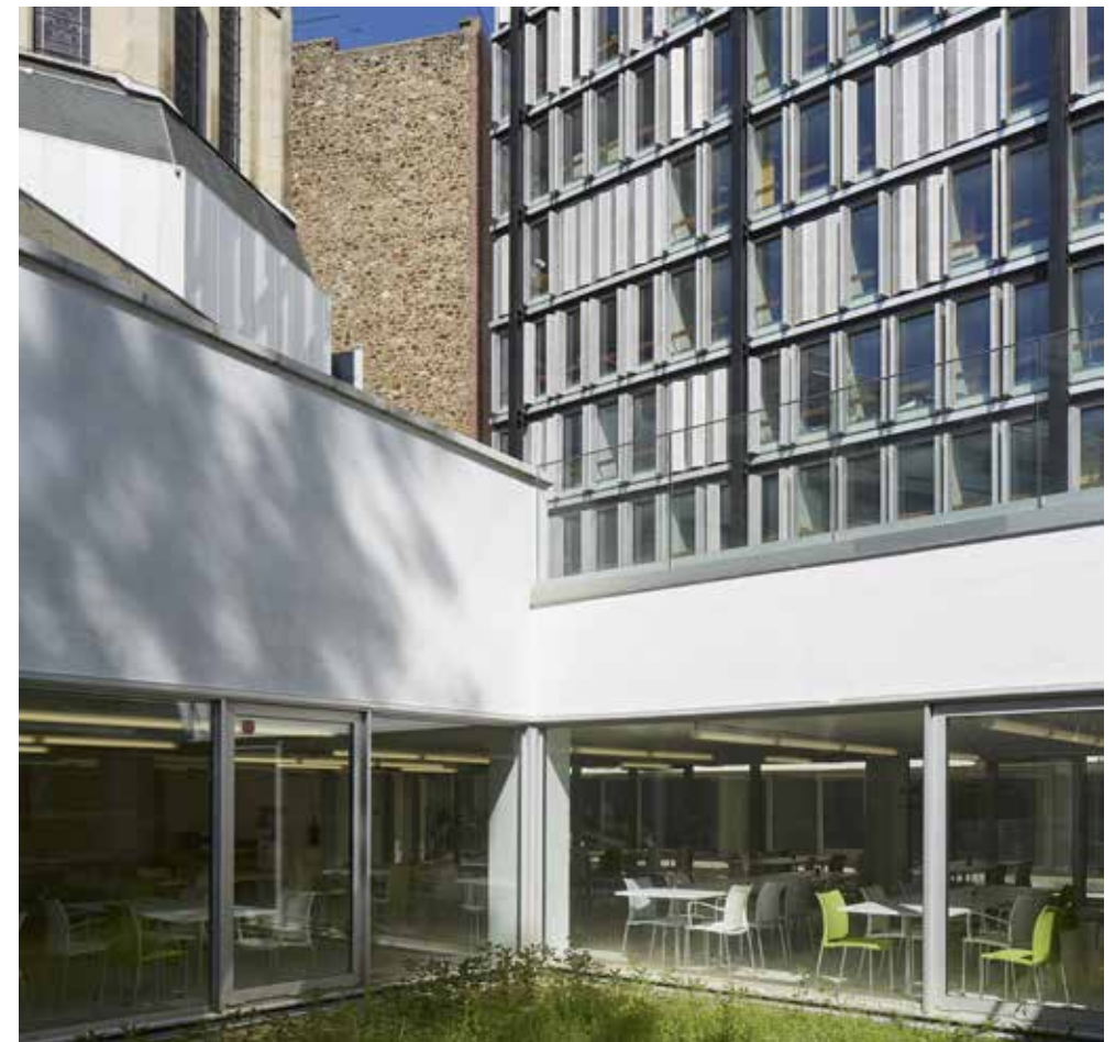
La Maison des Sciences de l'Homme du boulevard Raspail à Paris, réhabilitée en 2017. © Antoine Mercusot
