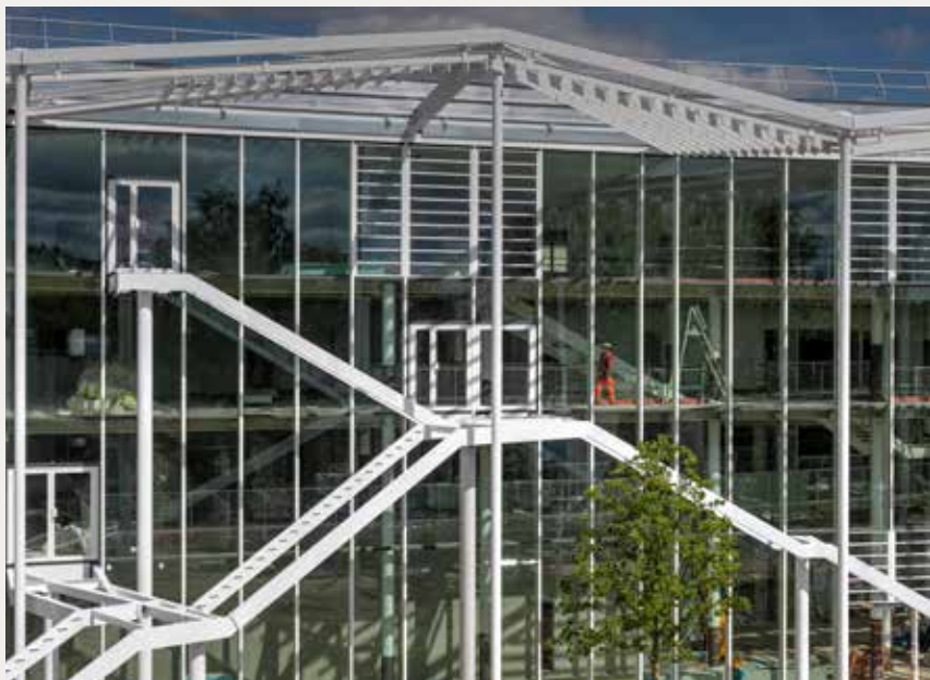
Le projet de Bâtiment d'Enseignements Mutualisés sur le site de l'École Polytechnique - Construction de la structure de la canopée, dans le prolongement de la large façade orientée à l'ouest vers le Green © Hélène Peter
