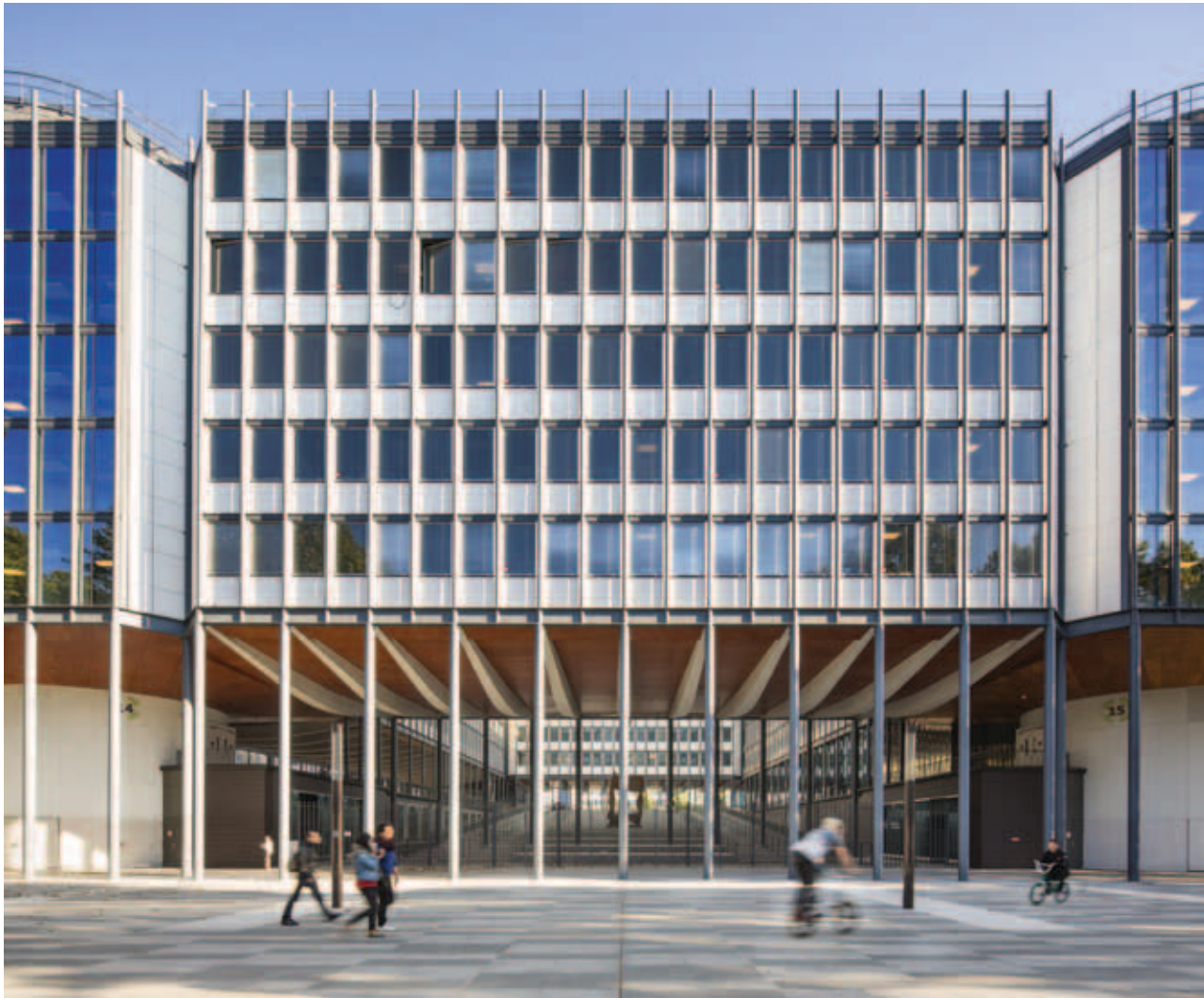
Après rénovation, le secteur ouest-centre est directement accessible depuis la rue des Fossés Saint-Bernard par un escalier extérieur qui rejoint le parvis.
