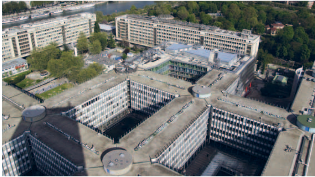
Le chantier du campus Jussieu, on aperçoit le Jardin des Plantes mitoyen via la rue Cuvier.
