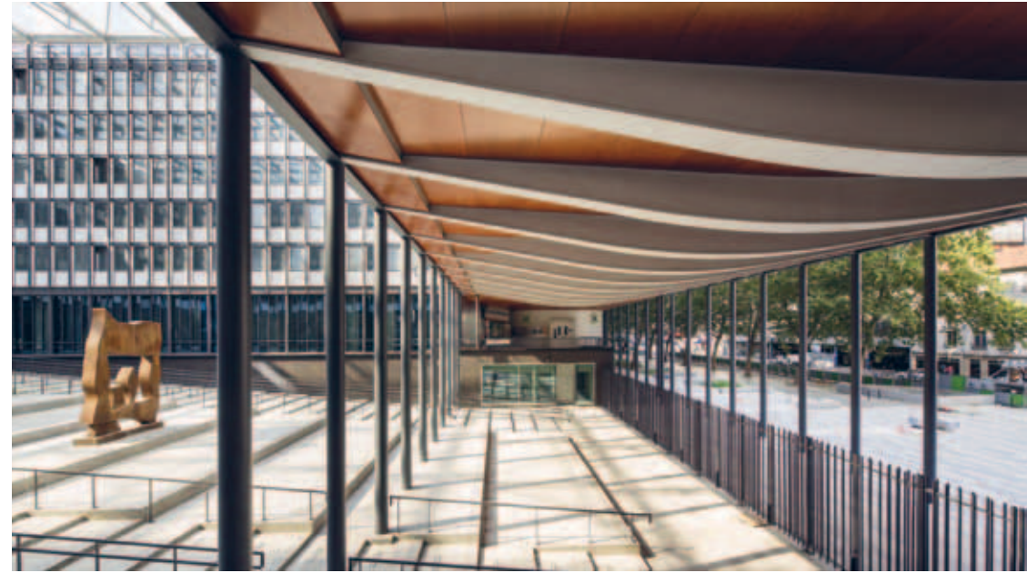
Au cœur de l'embarquement monumental du patio 14/25 on perçoit la structure sur pilotis des bâtiments, ainsi que le Petit Théâtre de Jean Arp, sculpture en acier issue d'une commande dans le cadre du 1% artistique.
